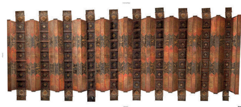
Figura 2. Ortomosaic desplegat a partir de la fotogrametria d'un sostre enteixinat. Ajuntament de Barcelona. Jaime Salguero, Krom Restauració SL, 2017.
