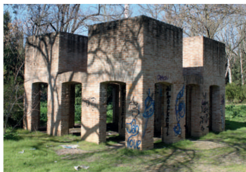
Figura 4. Estado actual de Escultura de ladrillo . Lara Rodríguez Seara, 2018.
