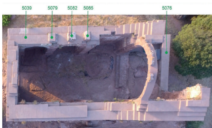
Figura 4. Vista aèria de l'església de Sant Genís, on es pot observar el tractament de consolidació aplicat als coronaments de l'edifici i on assenyalam també les UE. Alfred Mauri, 2019.
