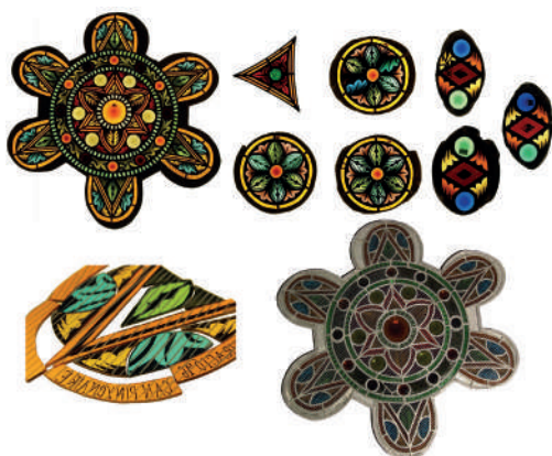
Figura 6. Plafons desinstal·lats de la rosassa després de la intervenció. Anna Santolaria, 2016.
