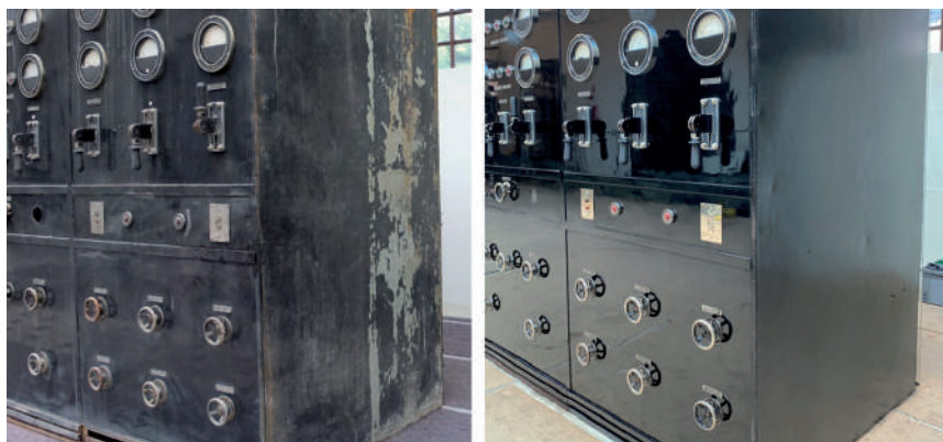
Figura 6. Detall del quadre de comandaments de l'emissor abans i després de la restauració. Mireia Garcia, 2022.
