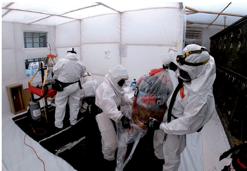
Figura 4. Sala de treball dins el confinament de l'emissor. Operaris amb els EPI retirant amiant d'una vàlvula col·locada a la taula de treball, i altres guardant el material contaminat en doble bossa, marcada amb el símbol internacional de l'amiant. Mireia García, 2020.
